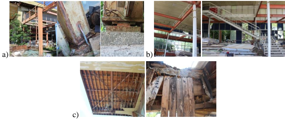
Slika 3 – Ocjena stanja građevine: a) vanjski elementi, b) unutarnji elementi, c) krovšte
