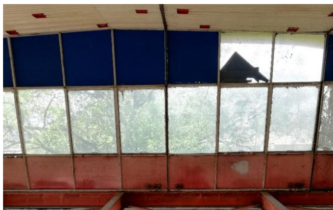
Slika 35. Pogled na fasadni element oslonjen na međukatnu konstrukciju.
