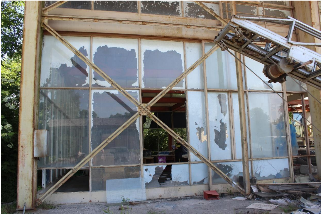
Slika 24. Vertikalni uzdužni spreg.
