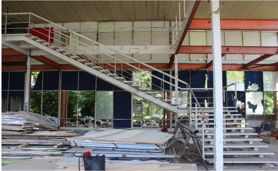
Slika 36. Pogled na unutarnje stubište.
