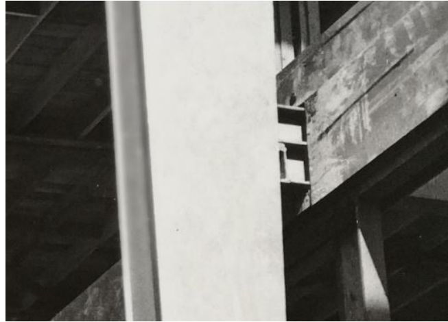
Slika 117. Ojačanje grede D14 na spoju međukatne konstrukcije i trozglobnog nosača.
