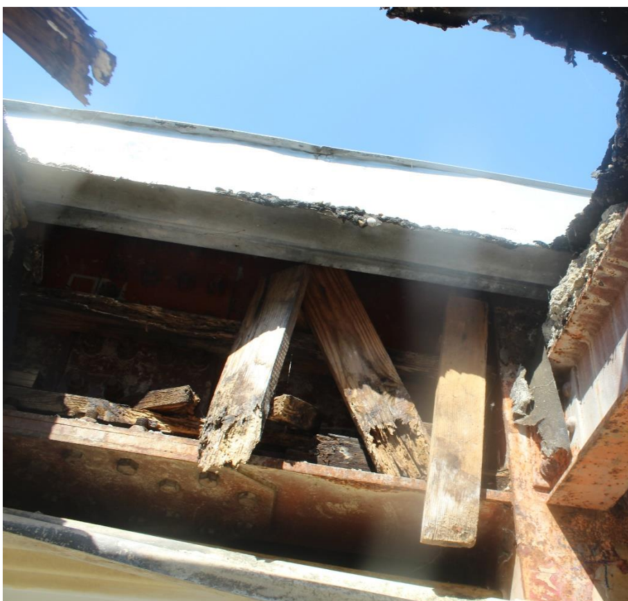
Slika 40. Detalj spoja stup – greda.
