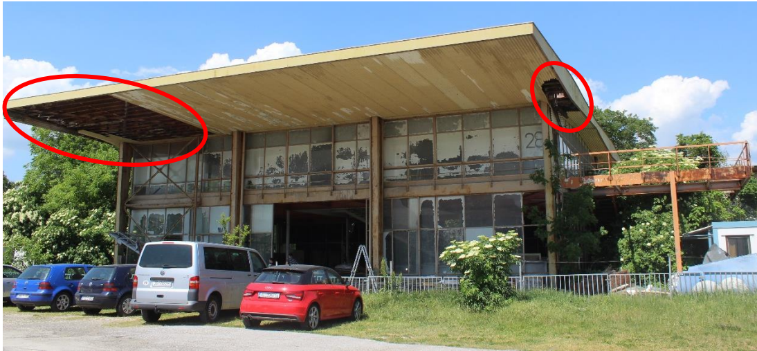
Slika 38. Pogled na paviljon s označenim mjestima vizualnog pregleda krova.
