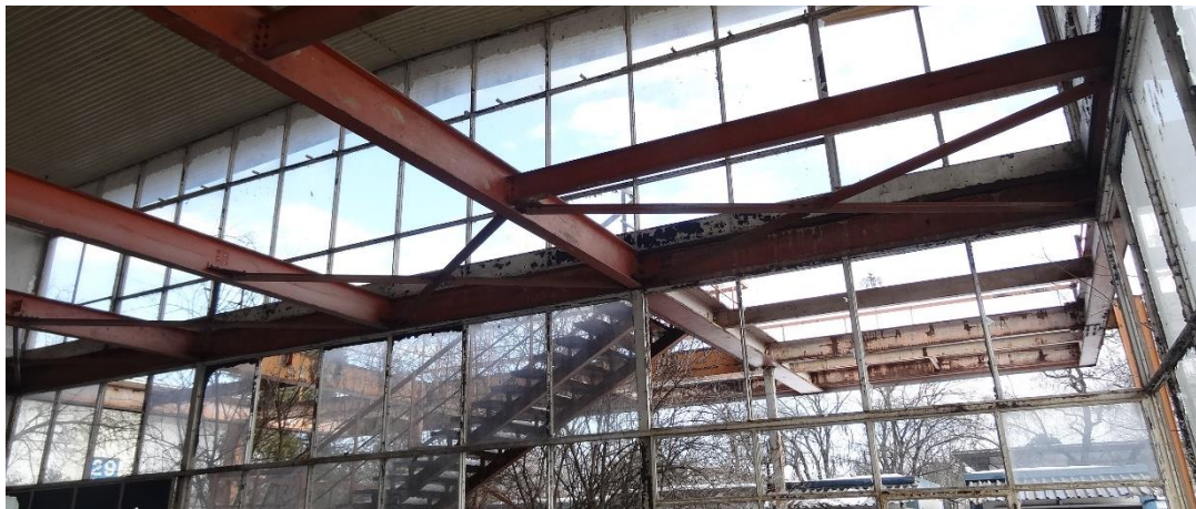
Slika 25. Horizontalni poprečni spreg u razini međukatne konstrukcije.
