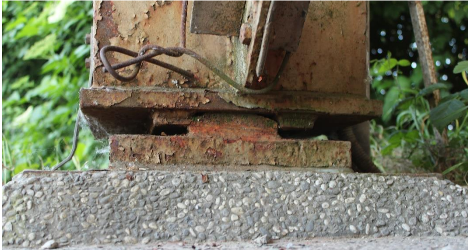
Slika 22. Fotografija zglobnog ležaja nosača.
