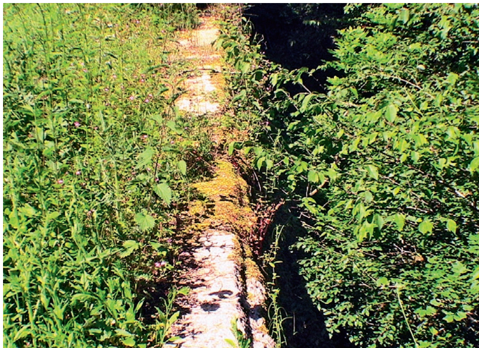
Pregrada u koritu bujice Duboka draga danas nakon uspješno izvedenih uzgojno-tehničkih radova i potpunog saniranja bujice (Foto V. Topić)
