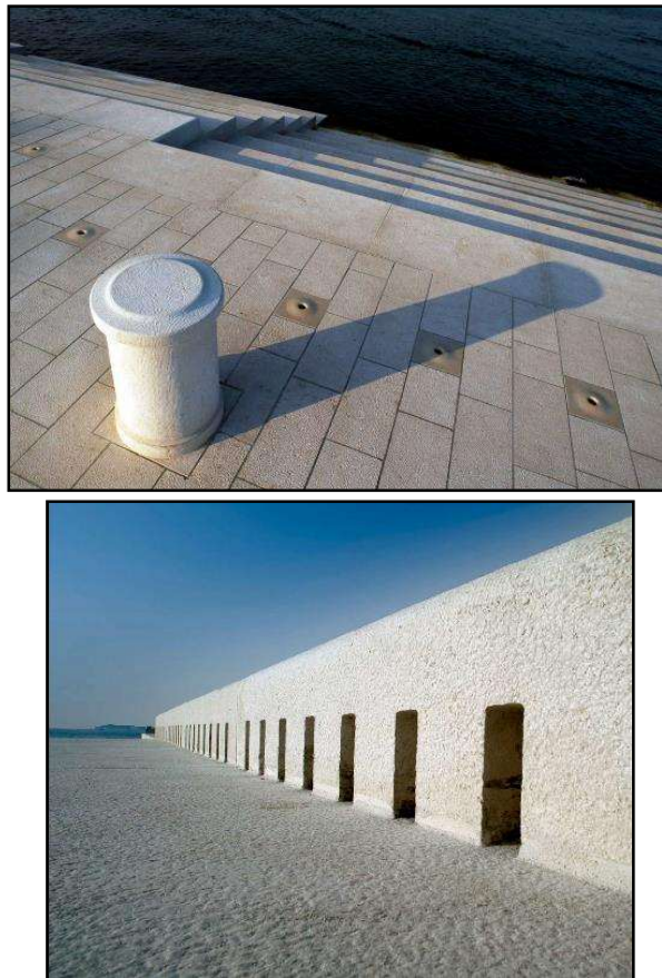
Slika 5. Gornji i bočni otvori za zvuk Morskih orgulja [1]
