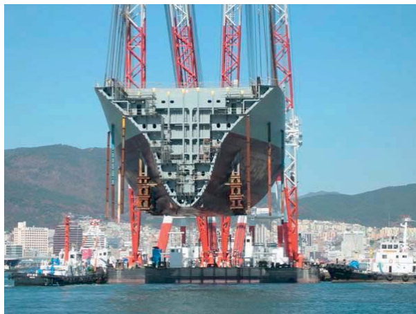
Slika 13. Plovna dizalica brodogradilišta Samsung pri podizanju megabloka
