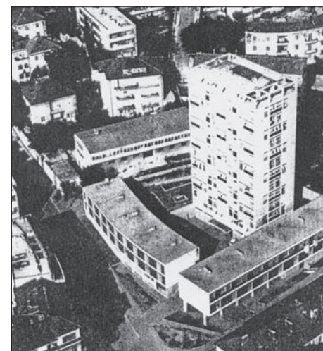
SL. 3. SKLOP NA KRIŽANJU DRŽICEVE I VIŠESLAVOVE ULICE, FOTOGRAFIJA SPOČETKA 1960-IH
