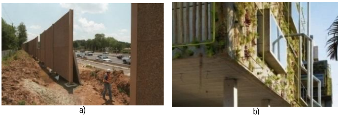
Slika 7 - Vertikalni elementi od propusnog betona: a) bukobran, [20]; b) pročelje uredske zgrade, [21] (slike uredili autori)
