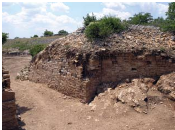
Sl. 38. Sjeverni ulaz, desna strana
