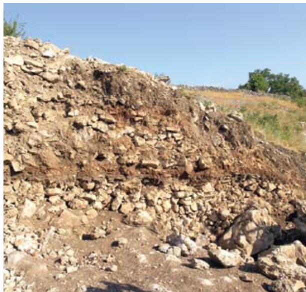
Sl. 29. Presjek slojeva jugozapadnog segmenta gledališta
