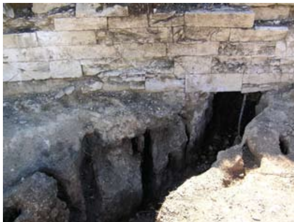
Sl. 47. Odvodni kanal u areni
