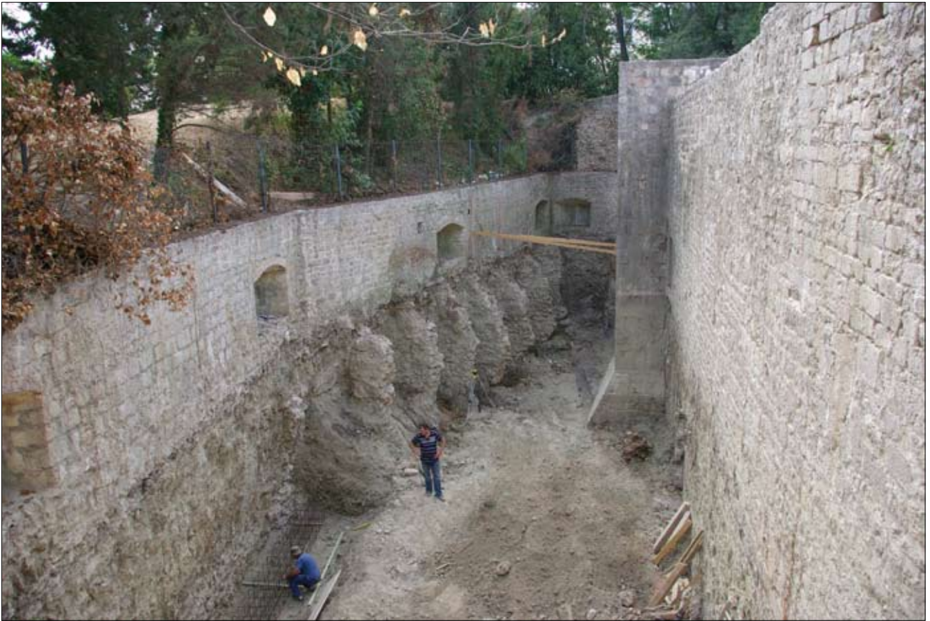
Sl. 3 Pogled na prostor Barbakana tijekom radova 2008.
