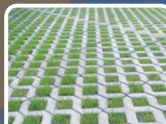
Betonske travnate ploče
