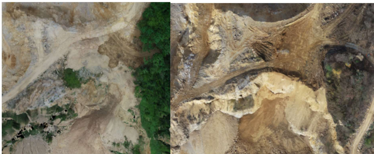
Slika 84. Novoizgrađena platforma (31.05 lijeva-19.11.desno)
