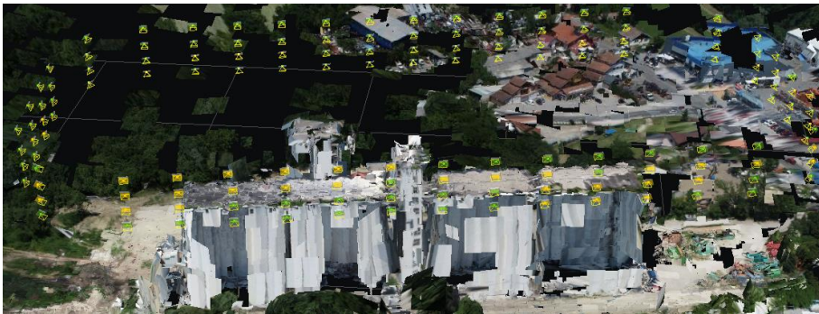
Slika 6.8 Rezultati provedene aerotriangulacije – naglasak na silos
