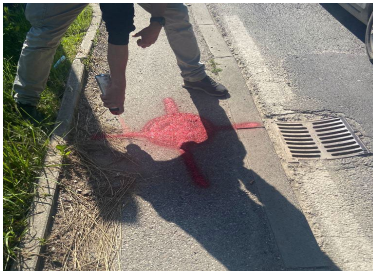
Slika 6.7 Signalizacija crvenim sprejom
