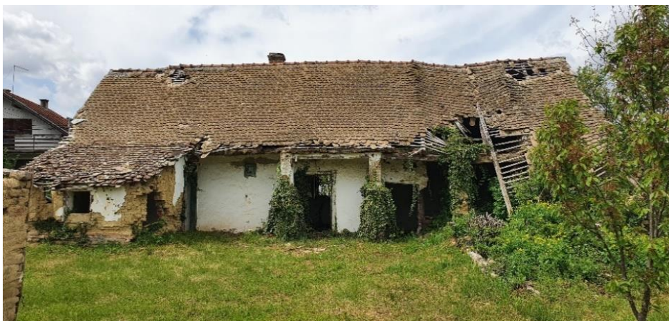
Slika 1. Tradicionalna kuća od nabijene zemlje u Aljmašu (Istočna Hrvatska)
