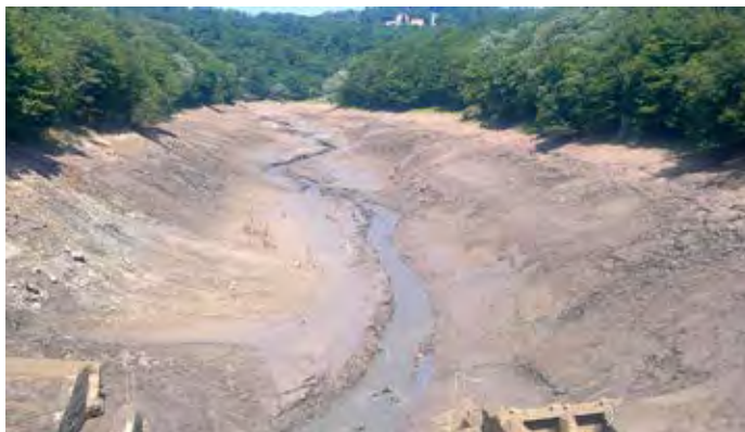
Slika 3. Prazna akumulacija Valići – 07.07.2014.
