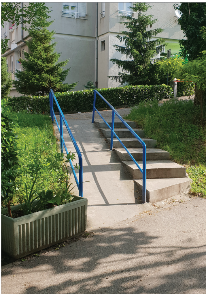
Sl. 9. Primjer rampe prestrme za prolaz invalidskim kolicima
