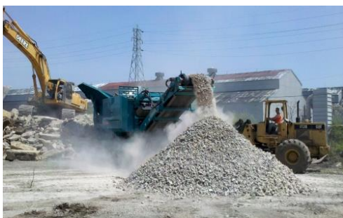
Slika 6. Reciklažno pokretno postrojenje [5].
