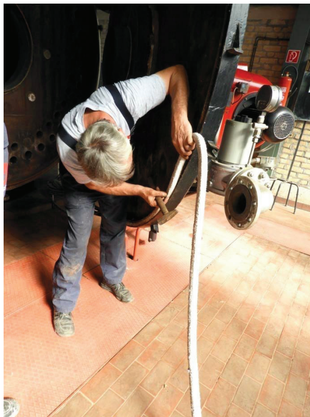
Sl. 4.: Izmjena brtve na prednjim vratima kotla
