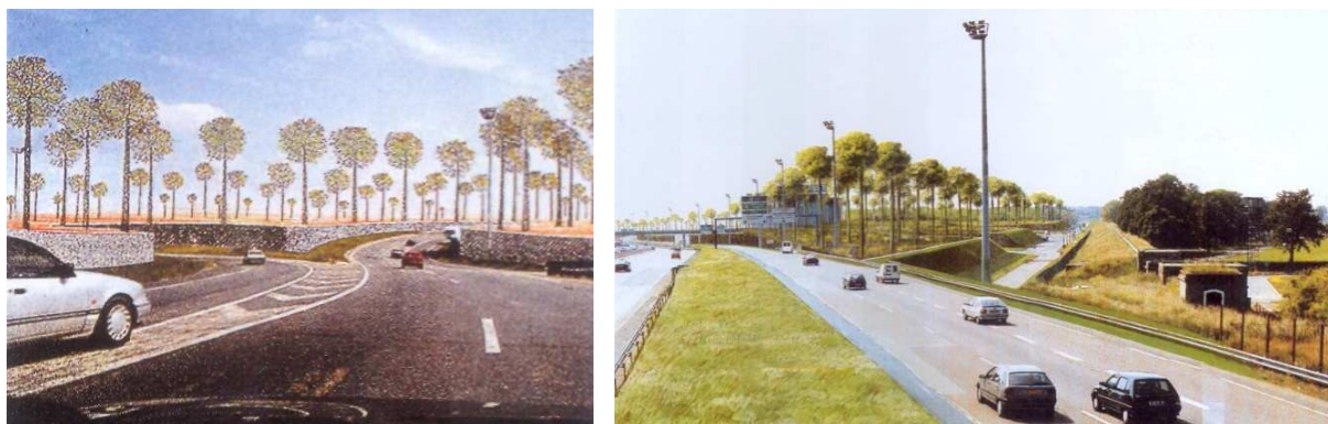
Slika 3. Vizure s ceste na dijelove istaknutog akvedukta (Izvor: Cribier)
