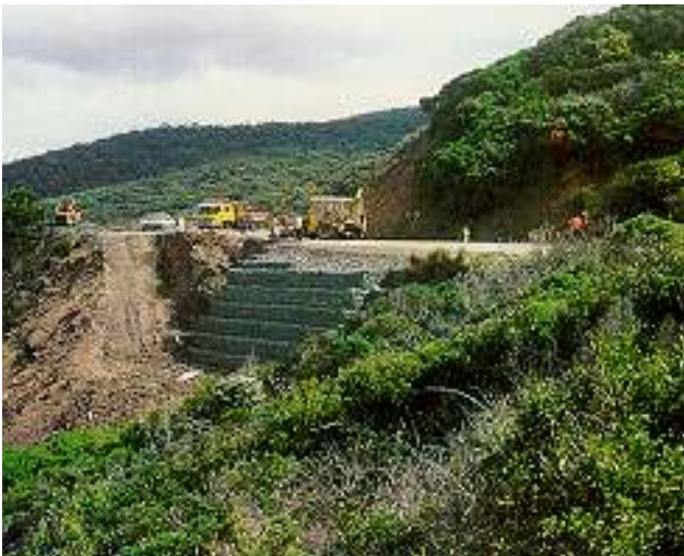
Sl. 11 Gabionski zid u fazi završnih radova
