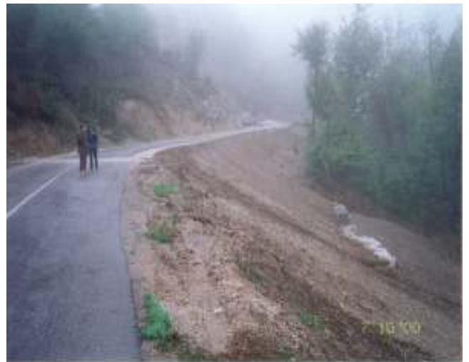
Sl. 12 Izgled saniranog odrona koji omogućava prirodno ozelenjavanje i pošumljavanje
