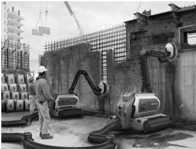
Slika 4 Primjena robota koji pri rušenju odmah otpad priređuju za ponovnu uporabu [18]
