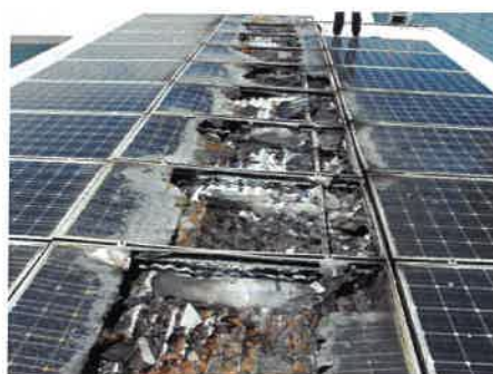
SLIKA 13. Primjer posljedice požara FN sustava, [9]
