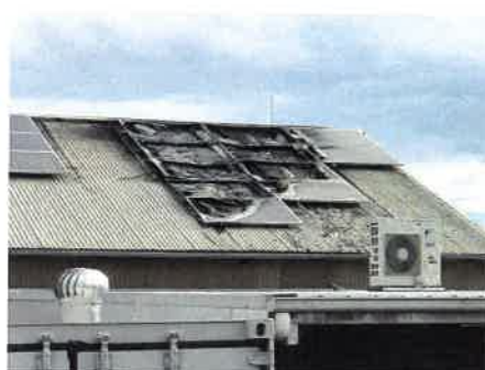
SLIKA 14. Primjer posljedice požara FN sustava [10]
