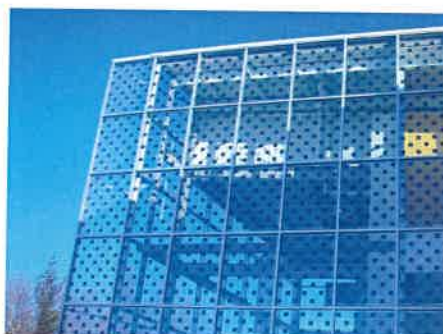
SLIKA 4. Fotonaponski elementi integrirani u fasadu, [5]
