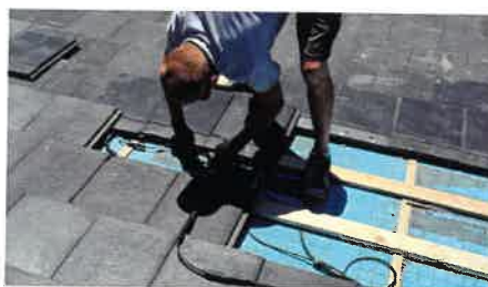
SLIKA 3. Pokrov s integriranim solarnim ćelijama [4]
